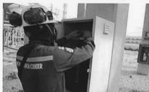
ภาพการตรวจอุปกรณ์เตือนเพลิง
