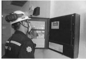
ภาพการตรวจอุปกรณ์เตือนเพลิง
